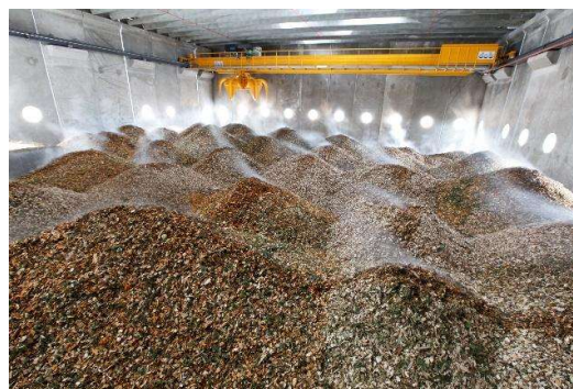
Indendørs flislager Biomasseanlægget
